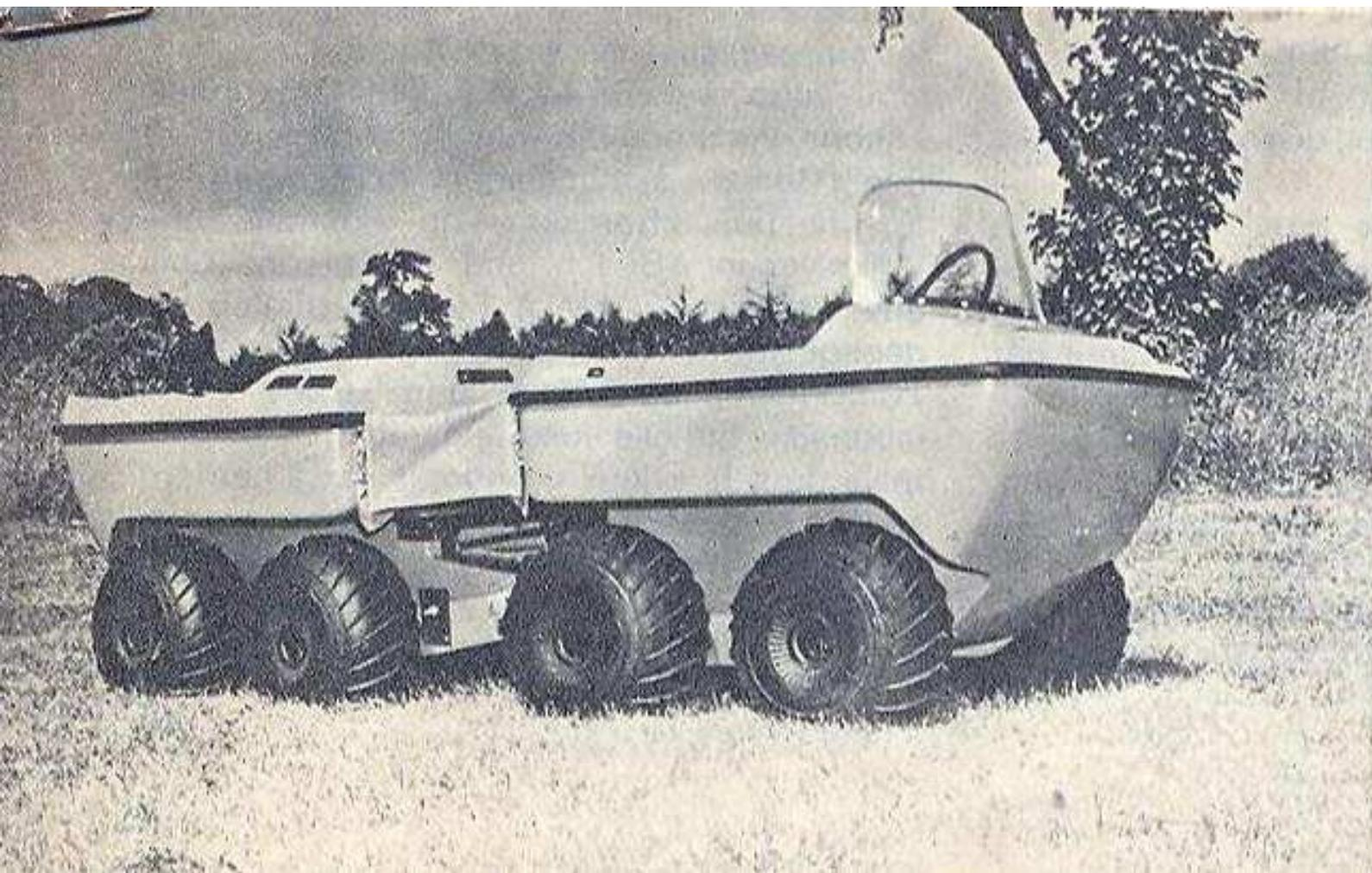
Ce véhicule amphibie est expérimental. Doté d'une carrosserie en polyester renforcé d'une résistance exceptionnelle, il est réalisé par la Good Year Aerospace. Baptisé « Surre Trek », il atteint 50 km/h sur le plat et 4 km/h sur l'eau pour 400 kg de charge utile.
