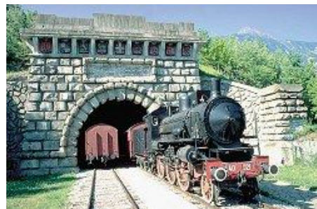
L'entrée du tunnel, côté français
