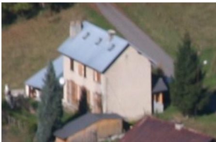
L'école de Montfort, reconstruite « en dur » en 1891
