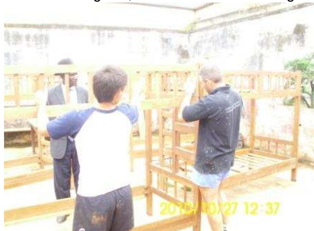
Séance de montage des lits réservée au dortoir par les jeunes de la Mairie de Villeneuve, assisté par le Chef service technique de la Mairie de Yaoundé 4ème
