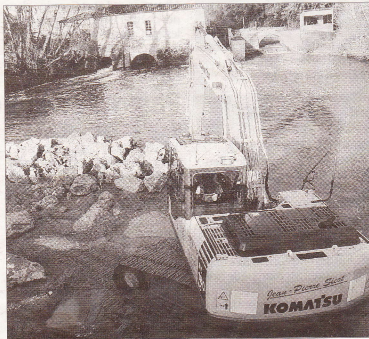
Le pont de Beaumont, à peine reconstruit, va bénéficier d'une protection supplémentaire. PHOTO MERRY CHIVOT
